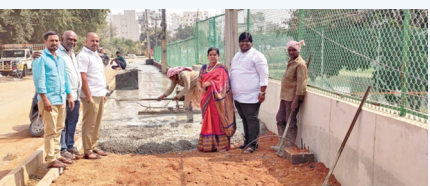
హైదరాబాద్‌లోని ఎర్రకుంట కట్టపై సుందరీకరణ పనులను పరిశీలిస్తున్న బండ్లగూడ కార్పొరేషన్ డిప్యూటీ ఛైర్మన్
